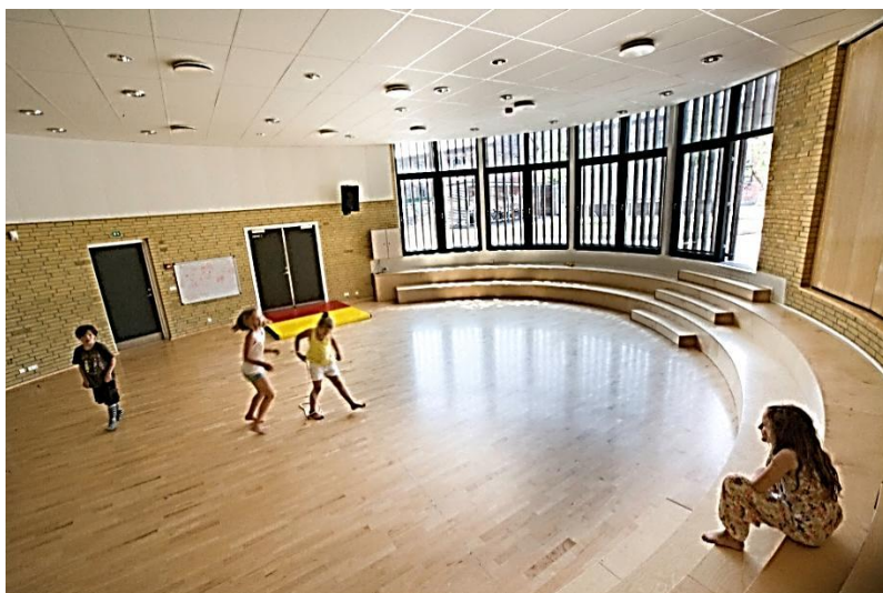
Tumlesalen i Nord – med lydabsorberende plader på væggen og nye lofter
